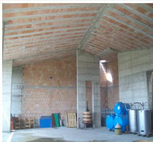
La struttura della nuova cantina ad Agosto 2013
